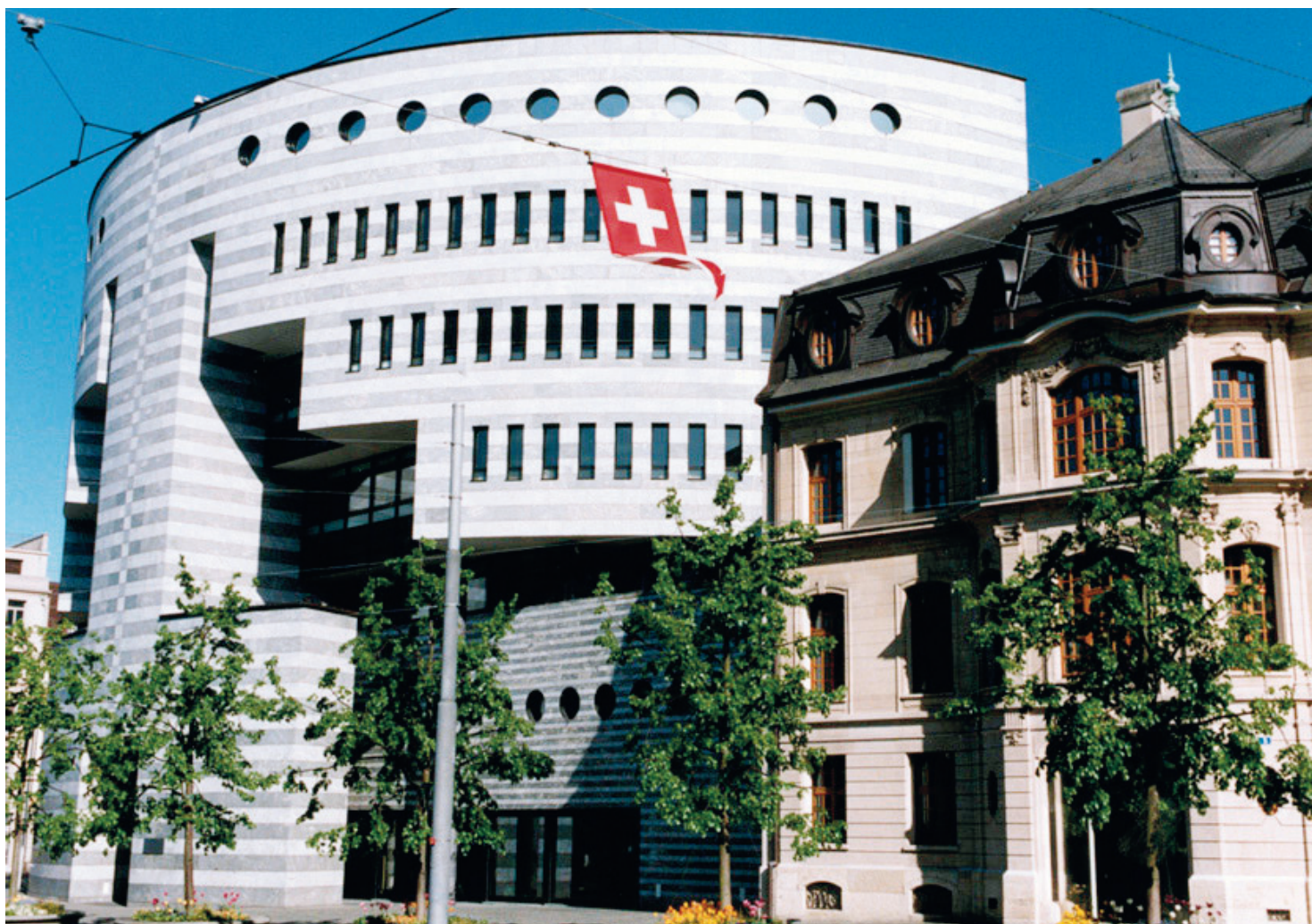
Il moderno edificio progettato dall'architetto ticinese Mario Botta è una delle sedi (l'altra alla pagina successiva) della Banca dei Regolamenti Internazionali, a Basilea, dove si riunisce la commissione che ha deciso le nuove regole patrimoniali. A sinistra, il direttore generale della BRI, Malcom D. Knight, già vice governatore della Bank of Canada
