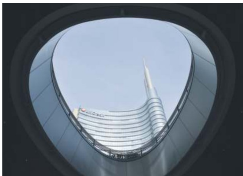
▲ La torre La torre Unicredit nel Centro direzionale di Milano
