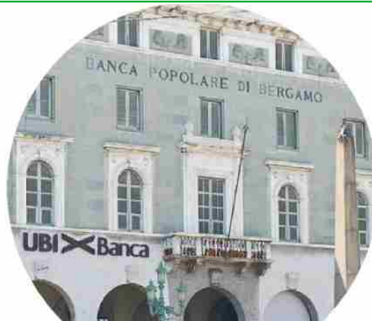
Piano in slittamento. Una delle sedi del gruppo Ubi Banca
