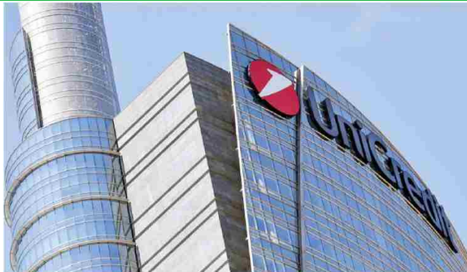
Il piano al via. La sede di UniCredit in Piazza Gae Aulenti a Milano.
