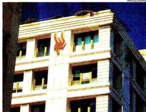
L'Istituto. Si lavora alla ristrutturazione della Popolare di Bari
