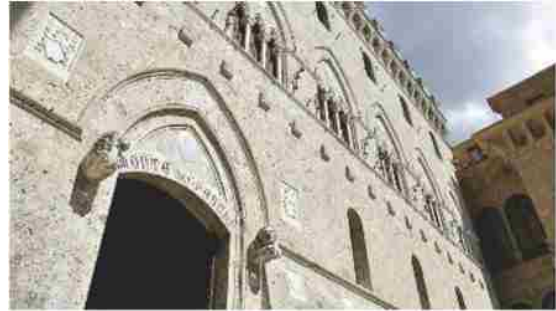
Palazzo Salimbeni è la sede di Mps, la banca più antica del mondo, fondata nel 1472 come Monte dei Paschi
