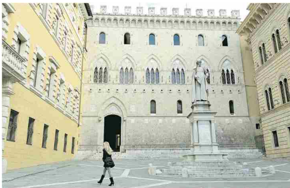
◀ La sede della banca Piazzetta Salimbeni a Siena, sede storica del Monte dei Paschi
