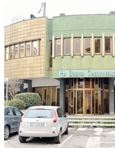
Uffici di Centropadana a Guardamiglio
