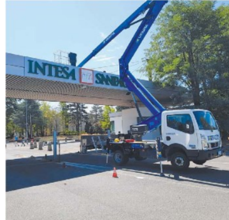
Nuova insegna installata all'ingresso del Centro direzionale
