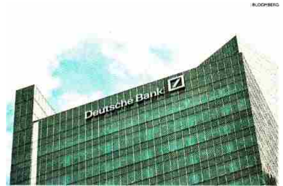
Nel post pandemia. In Deutsche Bank si potrà lavorare da remoto fino al 60%
